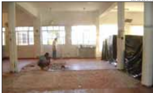
Início das obras do restaurante.
