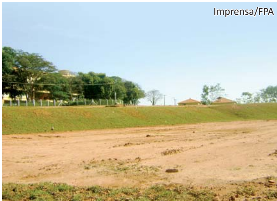
Área para construção das quadras, ginásio e piscina
